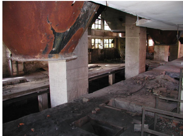
vnitřní prostory směšovacích zásobníků s výsypkami
